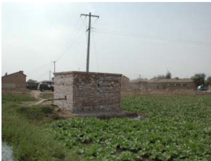
図 13 慢性砒素中毒の改善に用いた井戸（井戸水中砒素濃度：0.037ppm）
