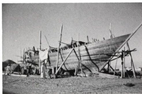
オマーン・スール港で建造中のダウ船 鋭く突き出した船首部は、ブーム型ダウの特徴。スール港は、オマーン・ダウの造船基地として知られ、平坦な砂浜のあちこちで50~60トン級のダウが造られている。
